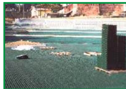
Fig. 3 Superficie durante la posa.
