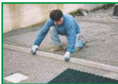
Fig. 2 Staggiatura e preparazione del fondo.
