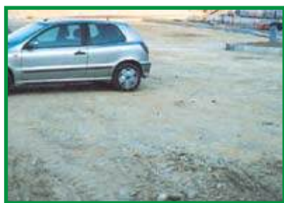
Fig. 1 Sottofondo ben compattato
